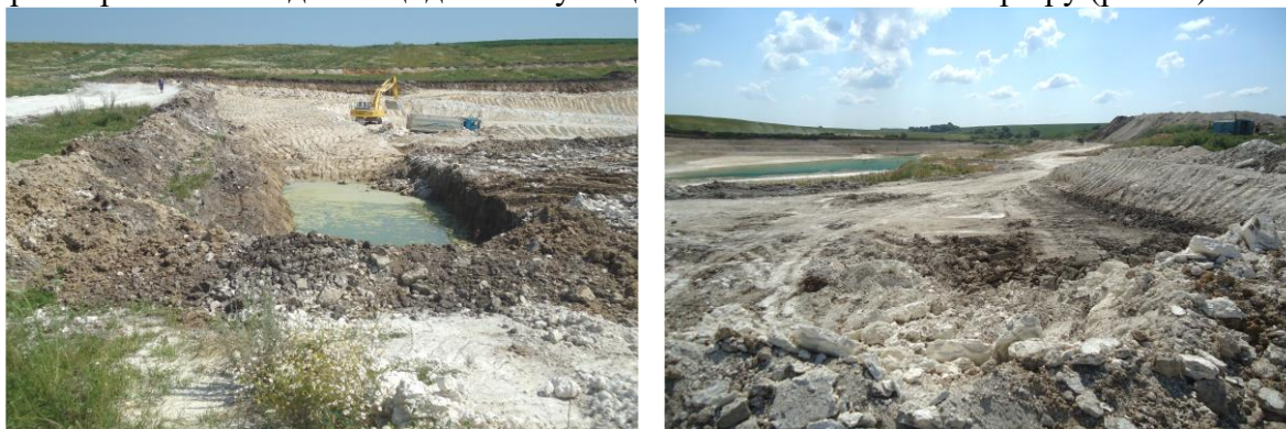
Рис. 23. Розкривні роботи при підготовці нового каолінового кар'єру до експлуатації
